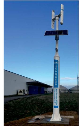
Das neue NTN Hybrid-Straßenlicht am Eingang unseres Werksgeländes zeigt allen Mitarbeitern und Besuchern, dass das Thema „Energie“ bei uns einen hohen Stellenwert hat. Diese energieautarke Beleuchtung, eine Kombination von Photovoltaikmodul, vertikaler Windkraftanlage und eingebauten Akkus, ist eine technische Erfindung und Entwicklung der NTN Corporation in Japan aus dem Programm „NTN Green Energy Products“.
