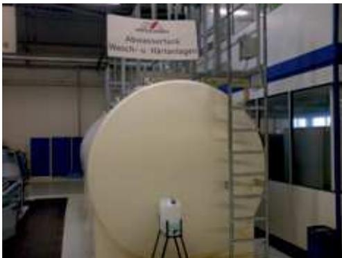
Tank (30 m³) für das Abschreck- und Waschmittel haltige Abwasser aus der Produktion
