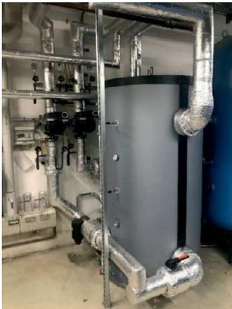
Etwa 15% des Stromverbrauchs an unserem Standort entfallen auf die Erzeugung von Druckluft für eine Vielzahl unterschiedlicher Prozesse in der Fertigung. In den Kompressoren wird ca. 70% des Energieverbrauchs in Wärme umgewandelt. Zum Schutz vor Überhitzung müssen sie gekühlt werden. Dies geschieht u.a. durch eine Ölkühlung im Inneren der Kompressoren. Mit diesem bis zu 90 Grad warmen Öl kann durch einen Wärmetauscher Wasser bis zu 80 Grad erwärmt und genutzt werden.
